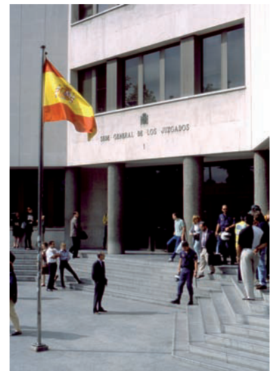
Edificio de juzgados.
